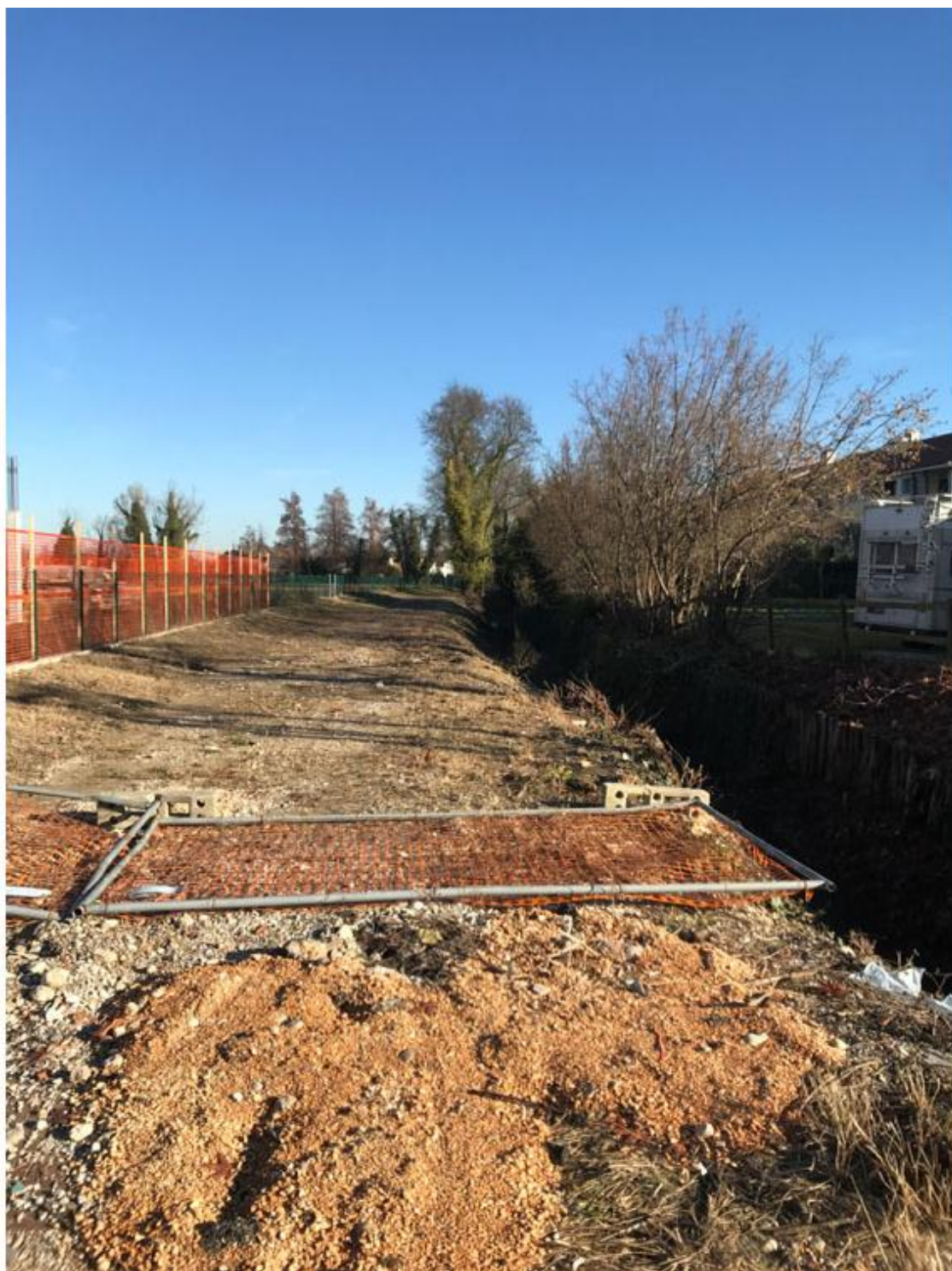
Figura 1 – I lavori di abbattimento della siepe riparia e spianamento della sponda sulla riva sinistra del Rio Boeto. Sulla sinistra è visibile la rete di cantiere della lottizzazione
